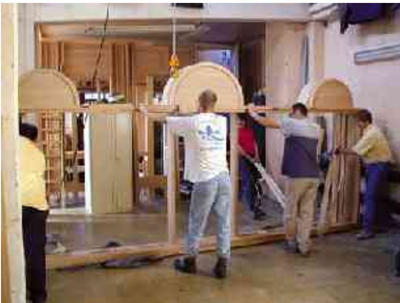
Das Muhleisen-Team beim Aufbau
